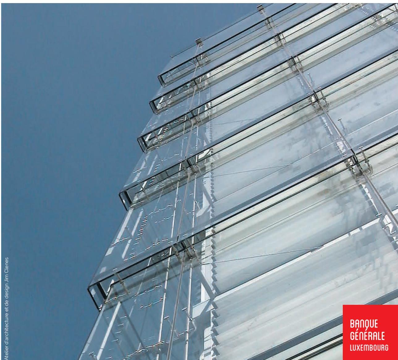
La technique VEA consiste à fixer des vitrages avec des composants mécaniques ponctuels.
